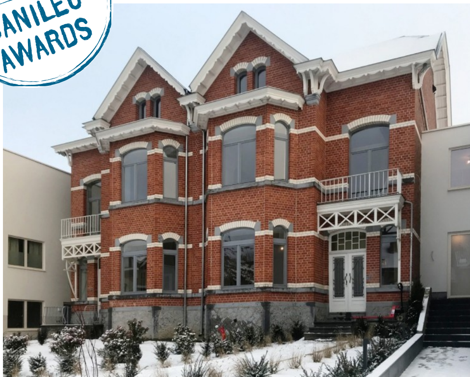
De verwarmingsinstallatie in dit project moest zowel voor de nieuwe lage-energie-woningen als voor de twee gerenoveerde serristenwoningen met hogere energievraag voldoen
